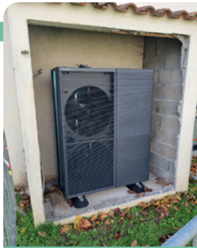
Installation d'une pompe à chaleur à la Maison des Associations
