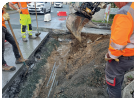
Réhabilitation du réseau pluvial rue des Ardilliers
