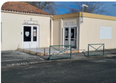
Aménagement d'un SAS devant la Garderie périscolaire
