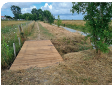
Nouvelle passerelle à la Coulée Verte
