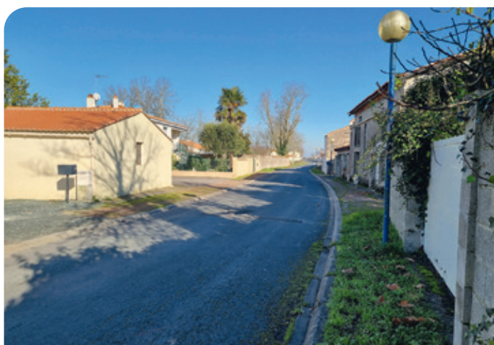
Réfection du réseau d'assainissement de la Rue des Ardilliers
