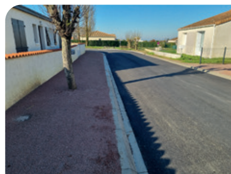
Travaux voirie - Rue des Flocellières
